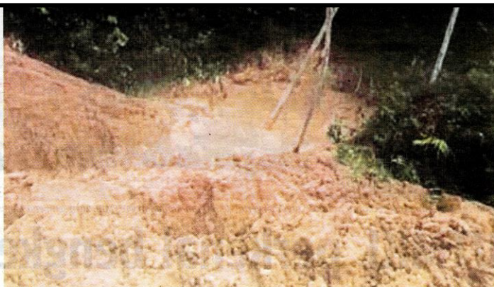
Aliran lumpur terkumpul dalam kolam enapan mengalir masuk terus ke sungai punca air keruh.
